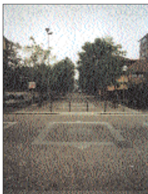
Figura 10 - Sistemazione di Via San Materno a Cinisello Balsamo Fonte: Nus srl Milano
